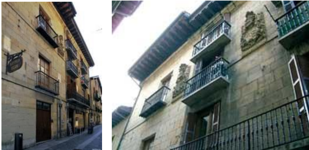
IMAGEN 1: FACHADA PRINCIPAL DE KAPITAIN ETXEA
