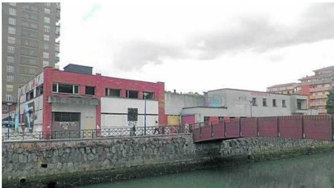
IMAGEN 12: LA FACHADA SUR DE LEKUONA ANTES DEL COMIENZO DE LAS OBRAS DE RENOVACIÓN
