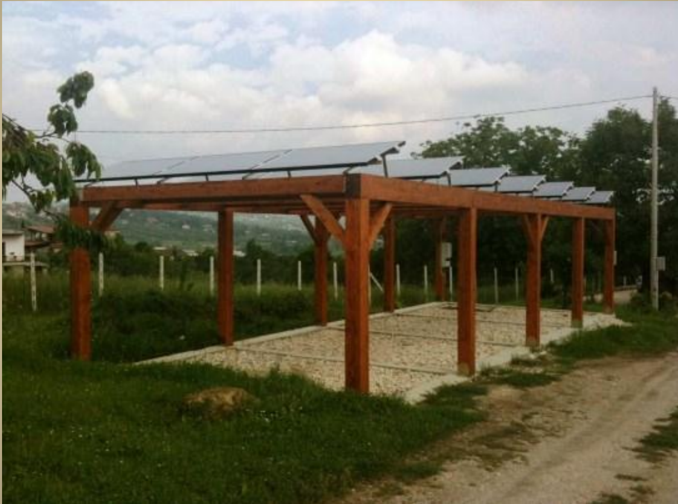
Sistema non integrato: esempio di pergola fotovoltaica
