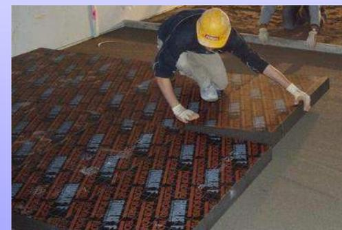
Il materiale è facilmente lavorabile, il taglio viene realizzato mediante sega a mano.
