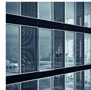
Impianto FV integrato
