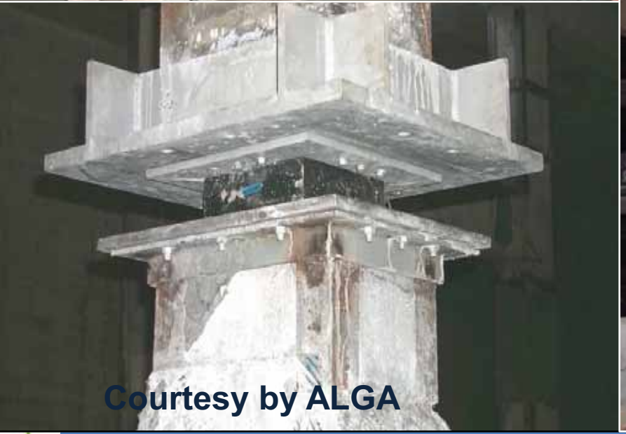
Taglio dei pilastri : inserimento dei dispositivi lungo i pilastri del primo livello e inserimento di un piano rigido
