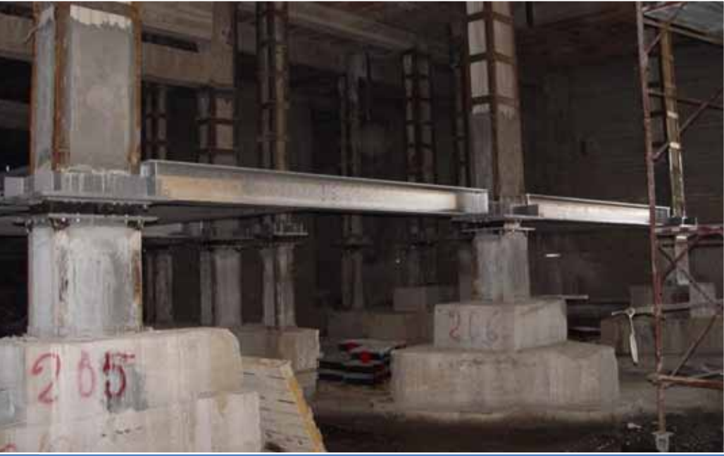
Taglio dei pilastri : inserimento dei dispositivi lungo i pilastri del primo livello e inserimento di un piano rigido
